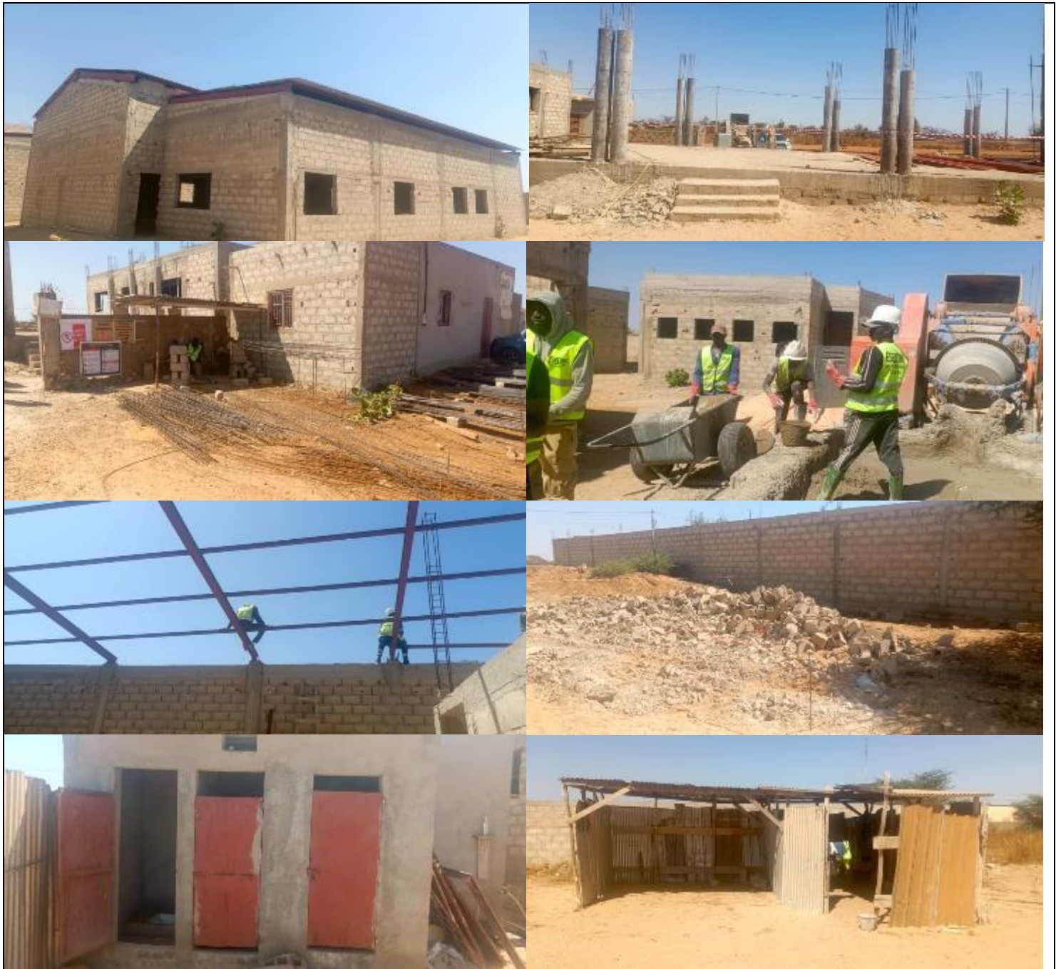
Photo 2 : Images illustratives du chantier du centre de formation aux métiers des peaux et cuirs de Meckhé (23/01/2025)
