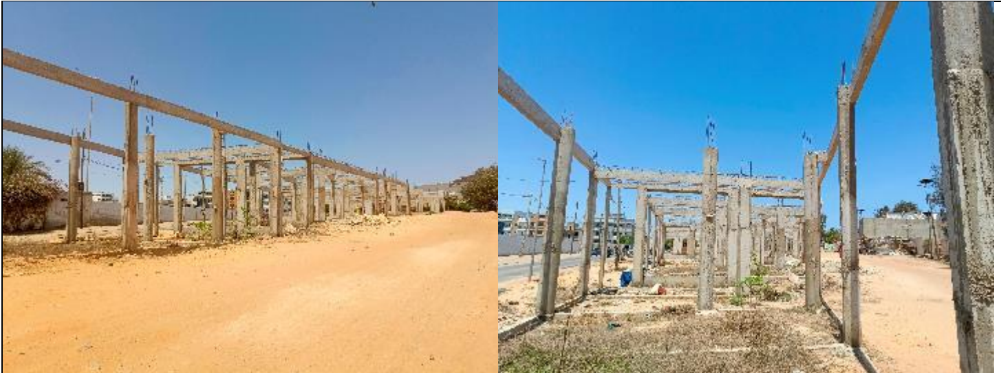
Photo 3 : Images illustratives du chantier du centre d'incubation de l'ITA (Travaux en arrêts) (16/05/2024)
