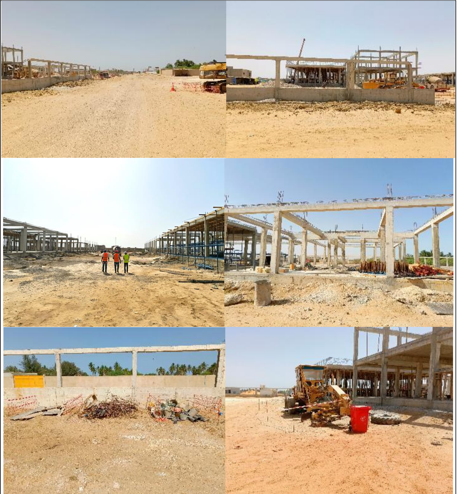
Photo 1 : Images illustratives du chantier du centre de formation aux métiers du pétrole et du gaz de Saint-Louis (08/05/2024)
