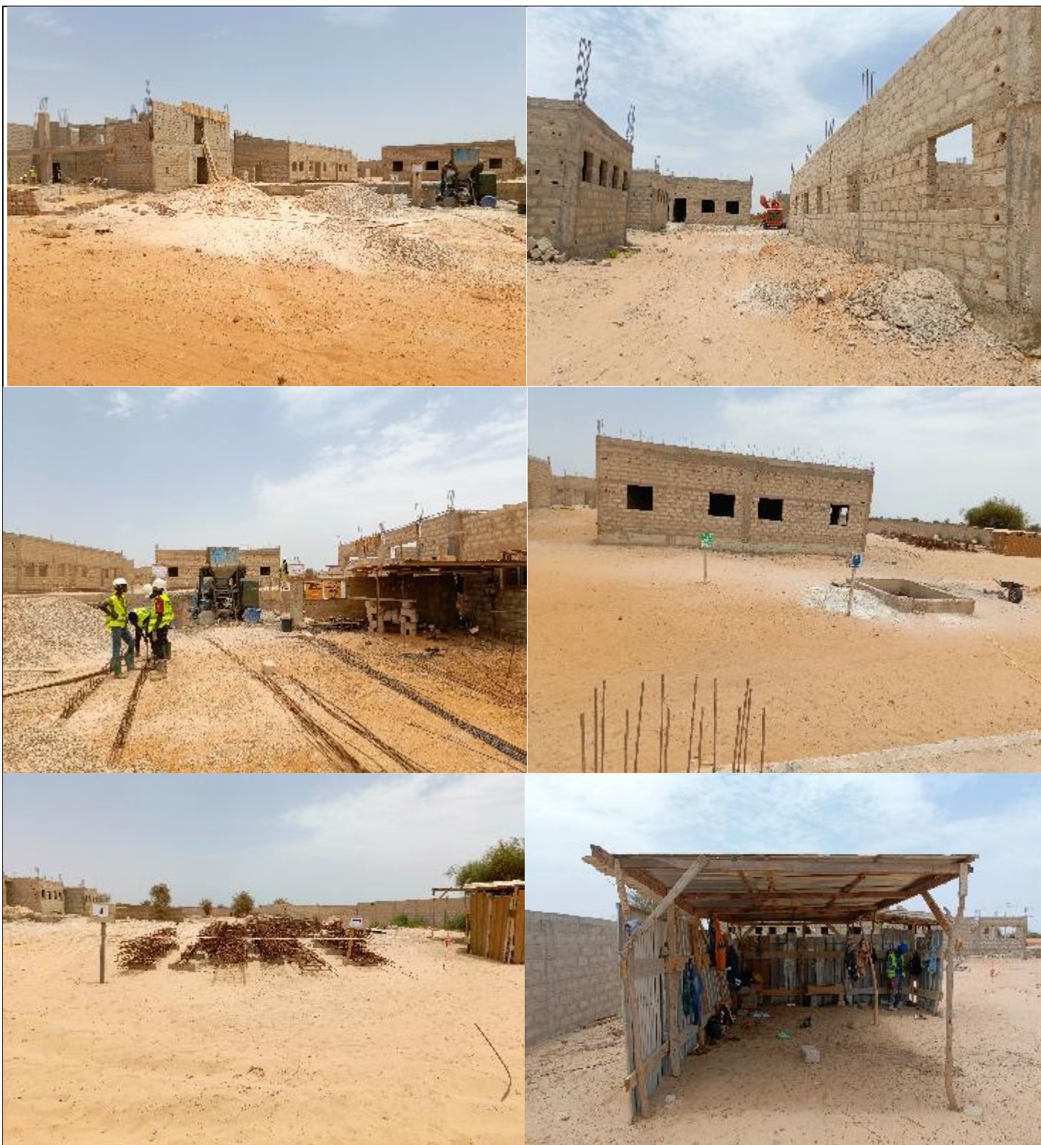
Photo 2 : Images illustratives du chantier du centre de formation aux m tiers des peaux et cuirs de Meckh  (09/05/2024)
