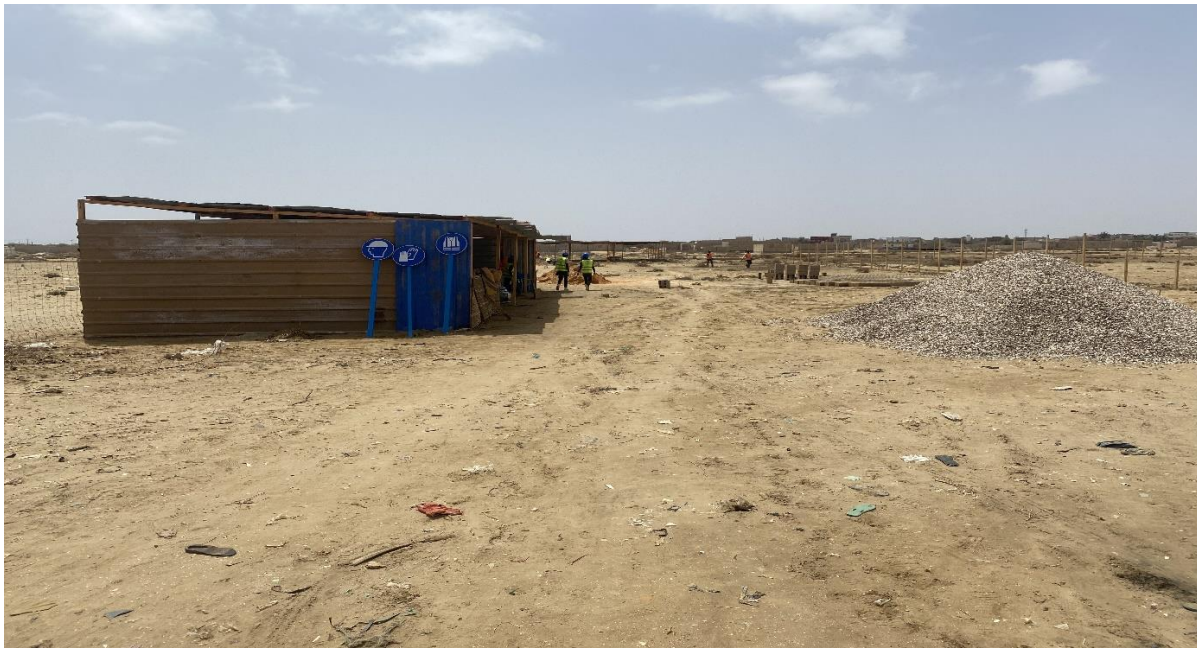
Photo 7 : Base vie avec des panneaux non installés
