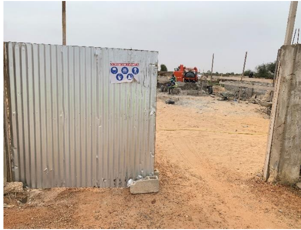
Photo 2 : Entrée avec la clôture en zinc
