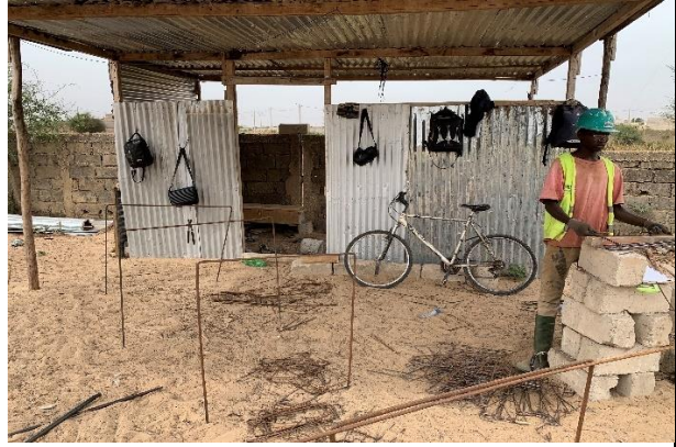
Photo 10 : installation de repos pour ouvriers
