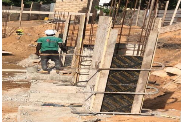
Photo 10 : Coffrage de pilon montante
