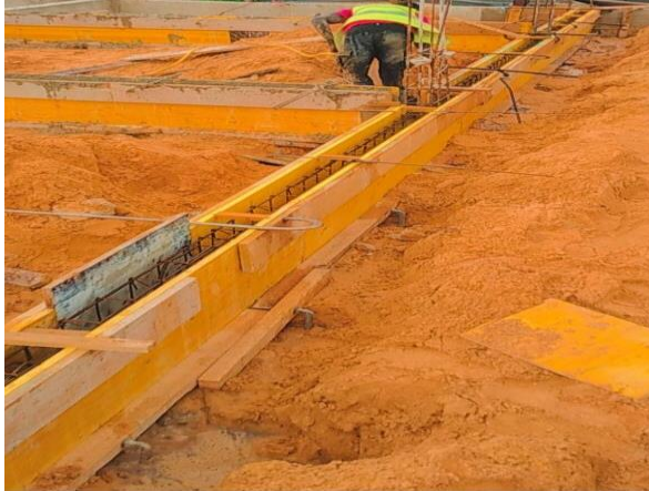
Photo 7 : coffrage de fondation
